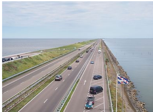
Extrémité occidentale de l'Afsluitdijk
